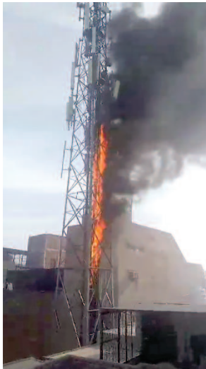
शहर की घनी आबादी में लगे मोबाइल कंपनी के टावर में लगी आग का नजारा।
