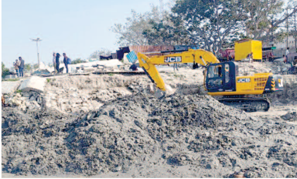
घाट निर्माण के लिए बालू को हटाने के लिए जुटी मशीन।
