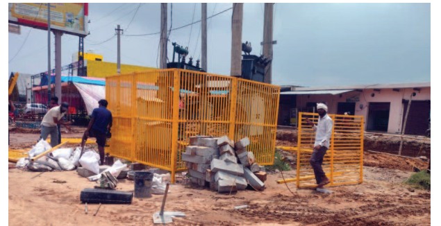
पूछरी के लौटा के समीप खुले में रखे ट्रांसफार्मर के चारों ओर सुरक्षा कवच तैयार करते बिजली कर्मी।
