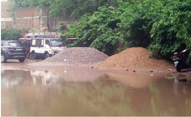
रोडवेज वर्कशॉप में निर्माण काम के लिए लाई गई गिट्टी और चंबल।
