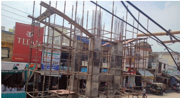
अधूरा पड़ा कोसी का घंटाघर निर्माण का काम।
